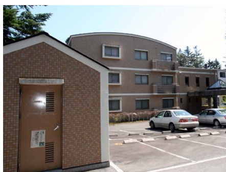
敷地内 ゴミ捨て場
