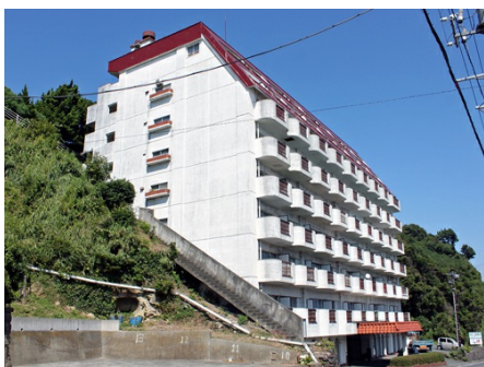
マンション全景
