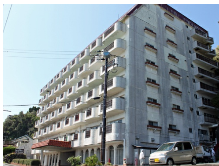
マンション全景
