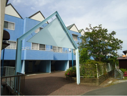
リゾートタウンハウス外観
