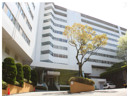
正面玄関付近
