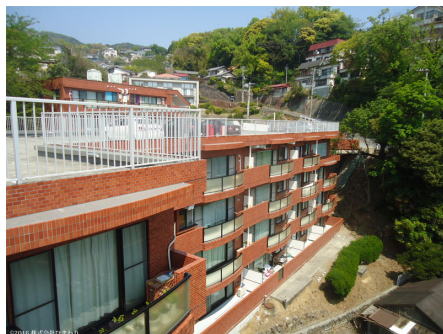
ロワジール伊東湯川
