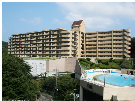
マンション外観 全景
