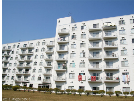
外観エントランス周辺
