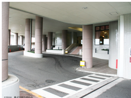
車寄せのあるエントランス
