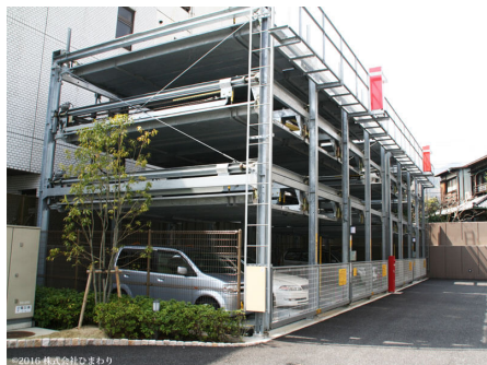
機械式駐車場
