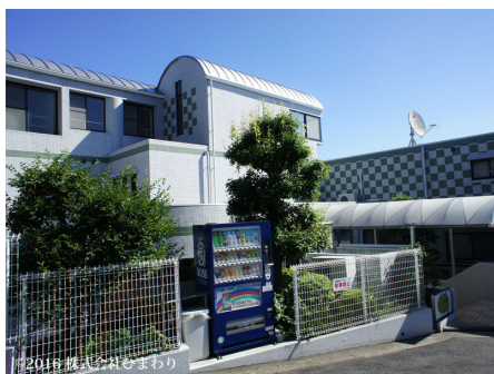
正面玄関付近
