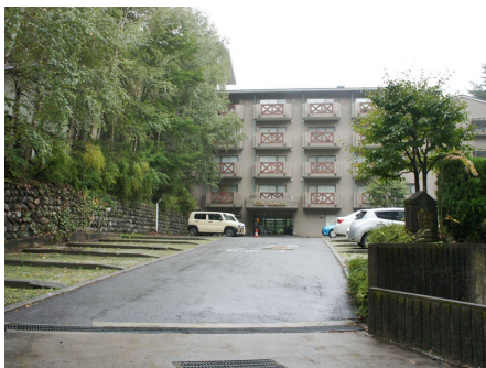
外観 前面道路より
