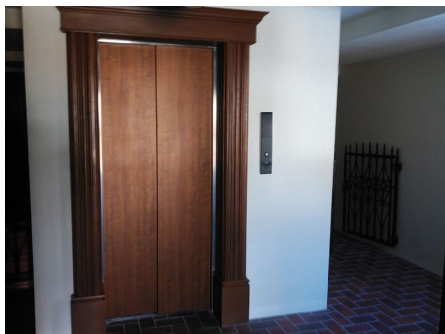
エレベーター（各棟に4基ずつ）
