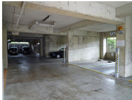
屋内機械式駐車場
