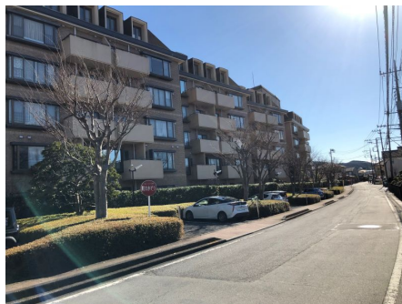
外観と前面道路
