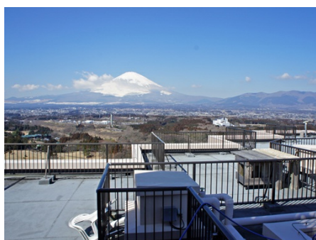
屋上からの景色
