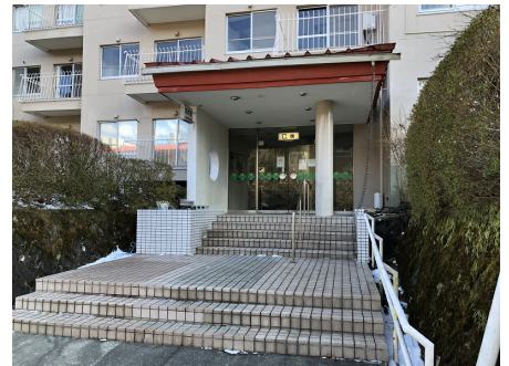
C棟エントランス
