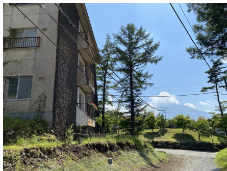
マンション外観 敷地内 富士山に向かって 建てられています。
