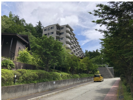
マンション前道路
