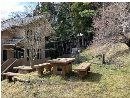
敷地内（小公園）
