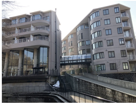
駐車場側より
