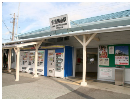
JR内房線安房勝山駅
