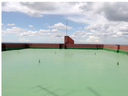
マンション屋上
