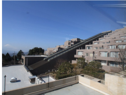
中央は斜行エレベーター
