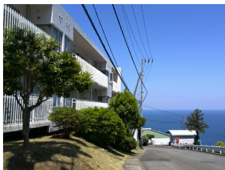
3号館(裏側に2号館があります)
