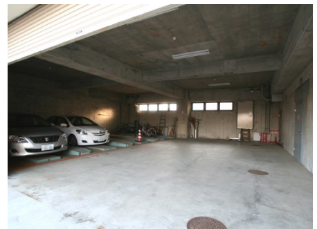
屋内機械式駐車場
