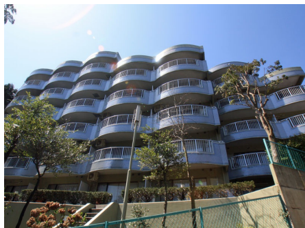
マンション外観 全景
