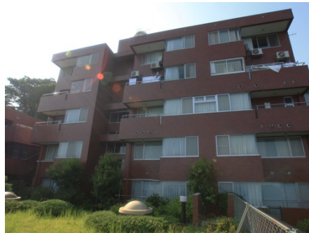
マンションB棟
