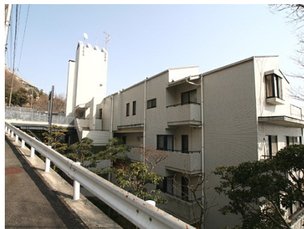
マンション入口側からの外観
