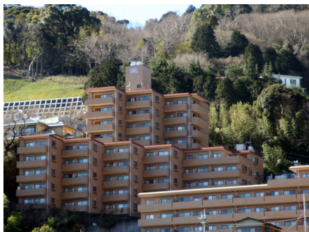
マンション外観 全景
