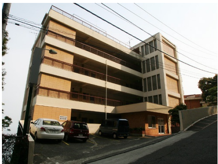
マンション外観と駐車場
