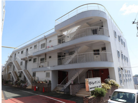
マンション外観：1号棟
