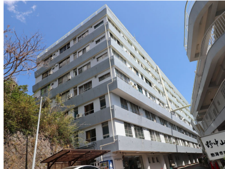
マンション外観：2号棟
