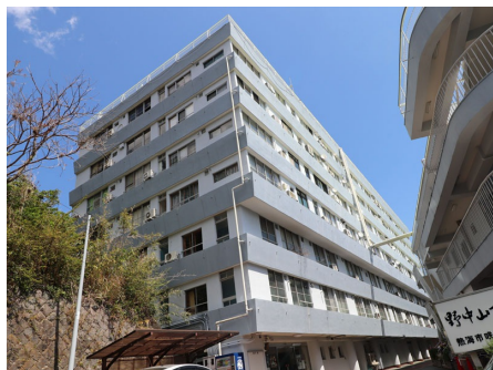
マンション外観：2号棟
