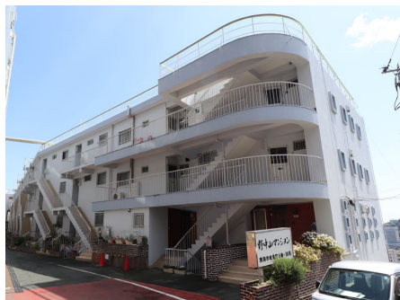
マンション外観：1号棟
