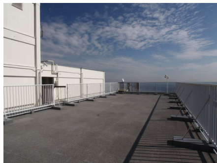
マンション屋上
